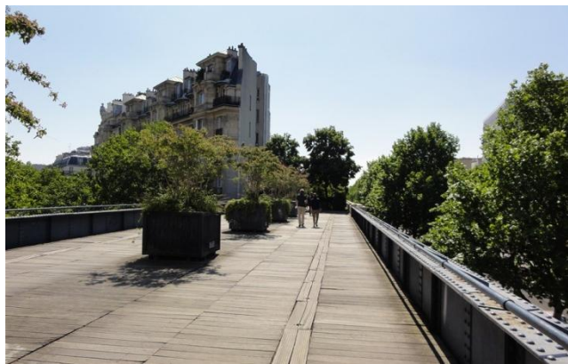
Pont au dessus du boulevard Diderot
