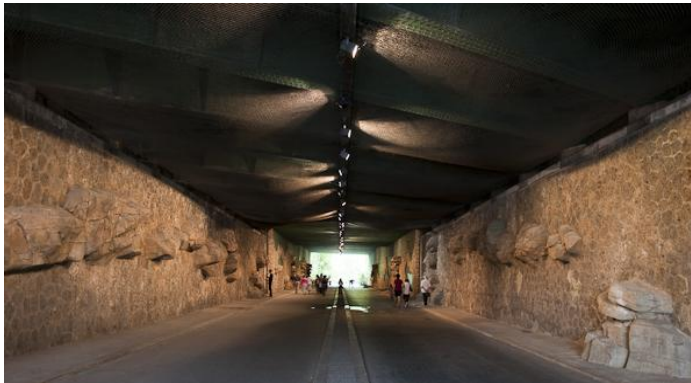
Tunnel de Reuilly
